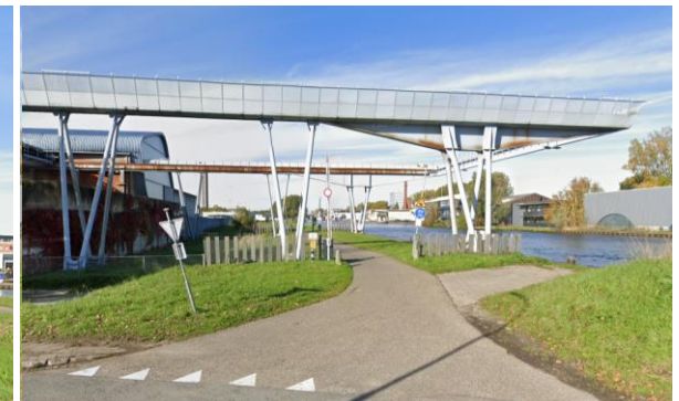
kaal maar ruim dijkprofiel bij de Avalet
